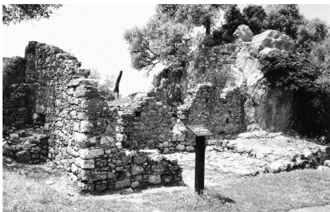
Lámina X. Vista de la Casa de Vegazo en "Ocuri".
