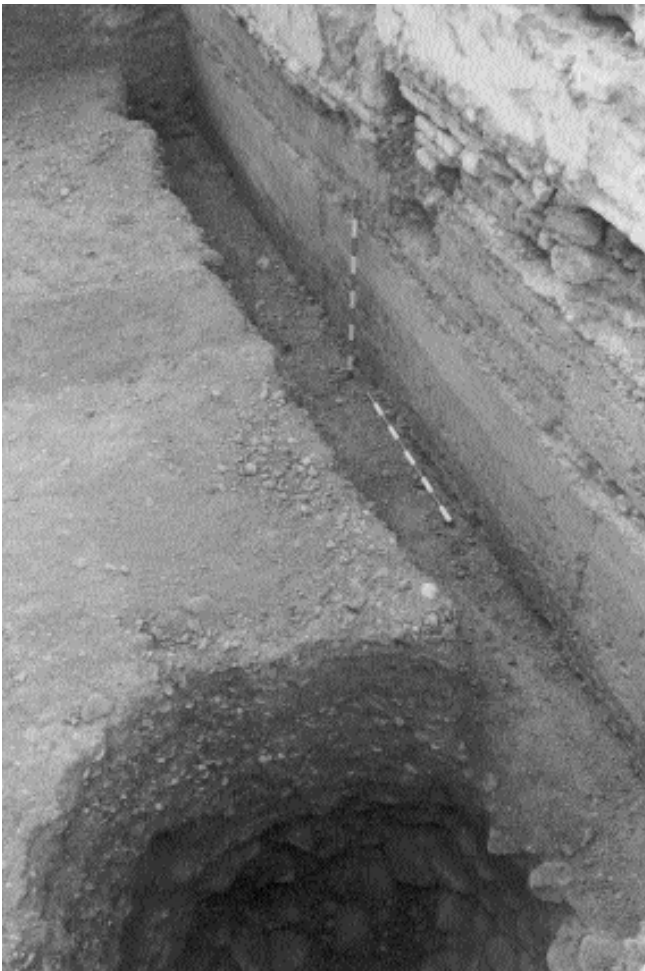
Fig. 6: Detalle de la zanja de cimentación (U.E. 22) de la muralla almohade.
