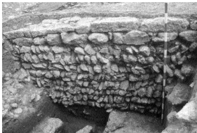
Lám. VI.- Detalle de la técnica de construcción de los muros altoimperiales.
