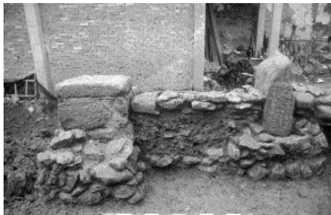
Lám. V.- Detalle de las construcciones romanas altoimperiales, que se abren a la calle central.
