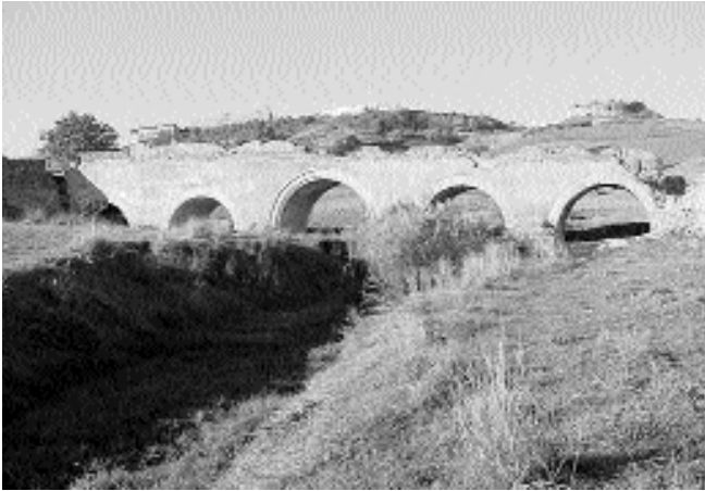
Lámina III. Cara meridional del Puente.
