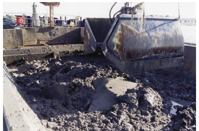
LÁM. IV. Vaciado de lodos en la cántara.
