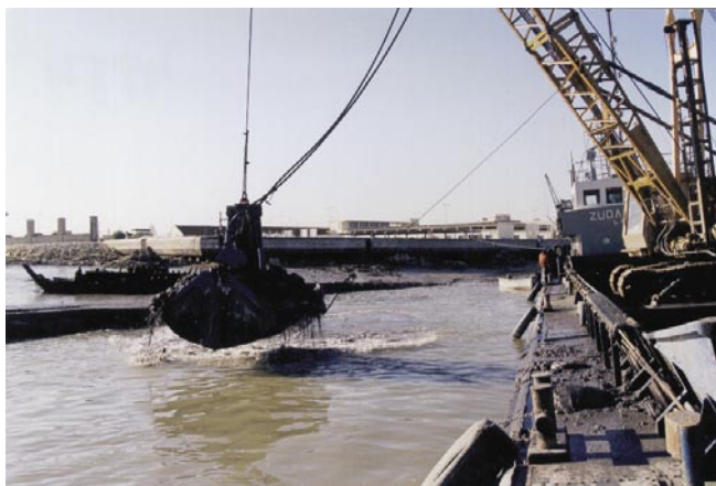
LÁM II. Proceso de extracción de los lodos.
