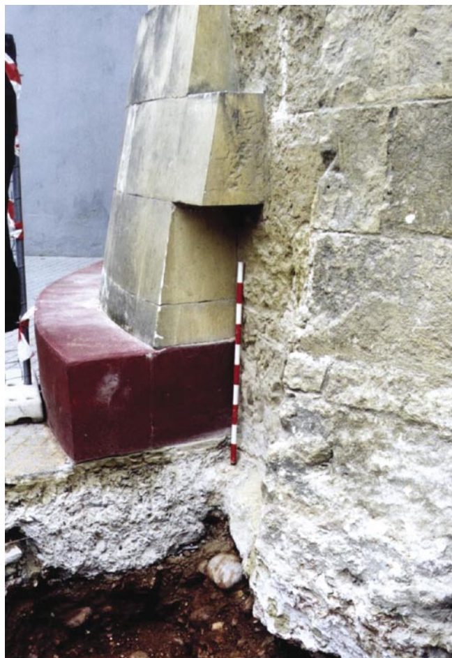
LÁM. VI. Detalle de la restauración contemporánea de la Torre.
