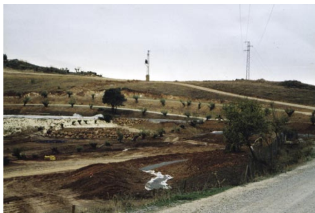
LÁM. I. Vista de la zona industrial del Caserío Porras desde el este.
