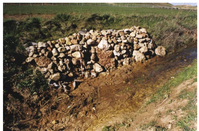
LÁM. V. Sistema de protección para el borno romano del Arroyo Villalta.
