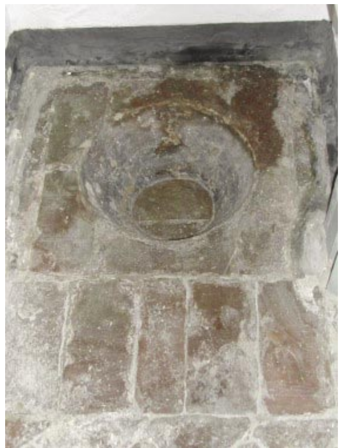
Figura 12. Tina encastrada en solería de ladrillos localizada en el Real Monasterio de Santa Clara de Sevilla. En este caso se halla en una de las celdas y funciona como soporte para colocar el bacín.
