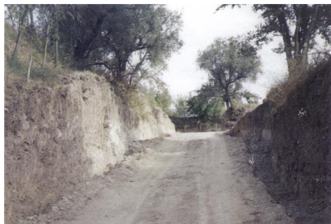
LÁM. 1. Vista general del desmonte del terreno dispuesto para el camino.
