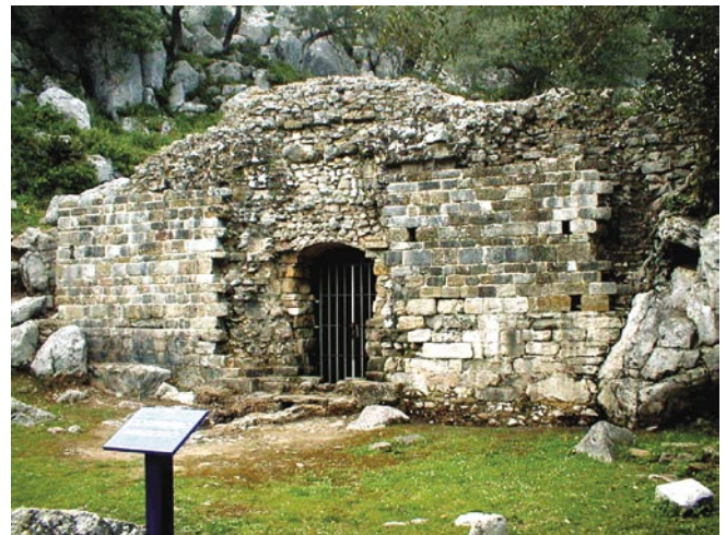
FIG. 10. Estado actual, tras su restauración, del Mausoleo/Columbario
