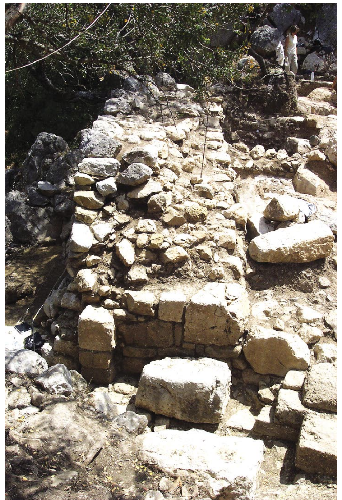
FIG. 2. Estado del lateral Este de la muralla al inicio de la intervención de 2003. Puede observarse el tamaño de los bloques y la anchura de la muralla.
