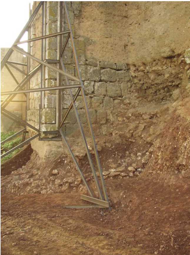
LÁM. II. Vista de la superposición de estructuras bajo la Torre 25.
