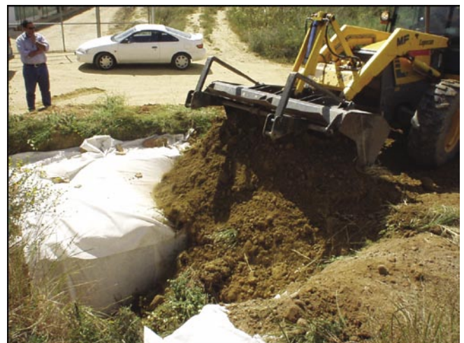
LAM. III. Retroexcavadora cubriendo la estructura.
