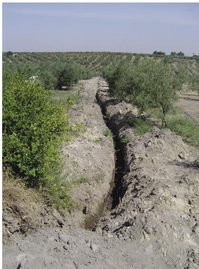
LAM. I. Vista general de la Zanja de soterramiento de cableado.
