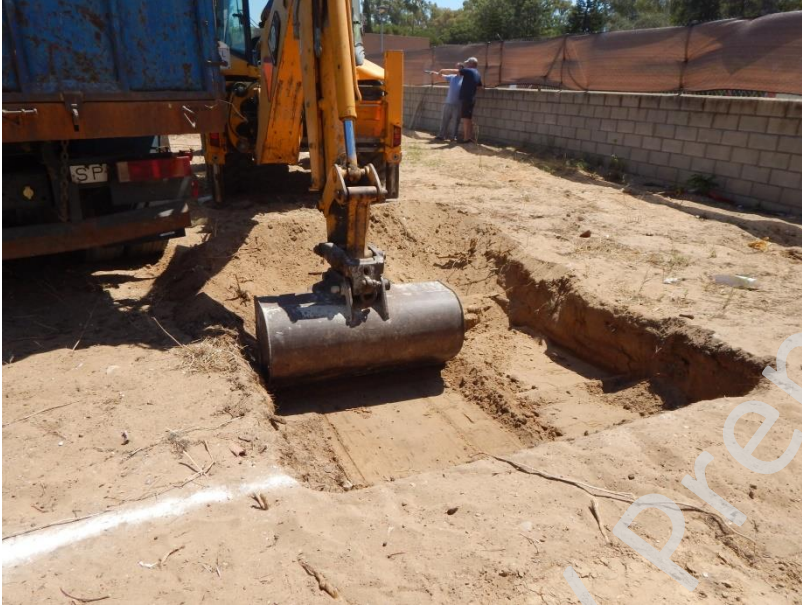
Detalle de la primera fase de la excavación.
