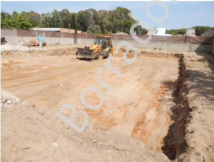
El solar, vaciado completamente a falta de la nivelación final.
