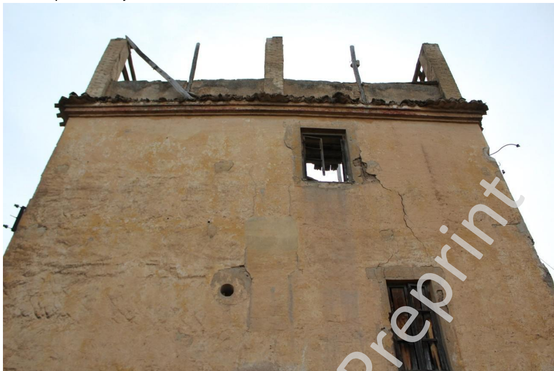
Detalles de la fábrica crujiás norte y oeste
