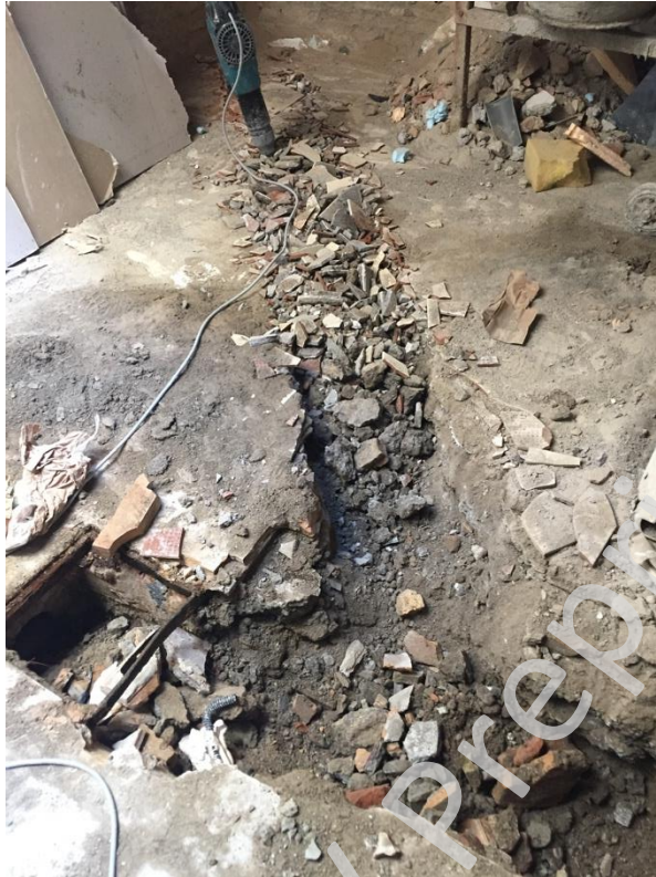
Figura 3. Proceso de excavación de la zanja del ramal de la bajante en el patio.
