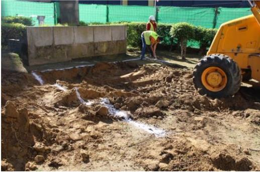
para poder realizar la rampa por la meterán la maquinaria de excavación retro-giratoria de mayor tamaño que es la que realizó la excavación.
