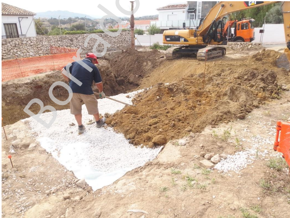
Lámina II.- Refuerzo de la protección del sector próximo al área donde se construirá la edificación
