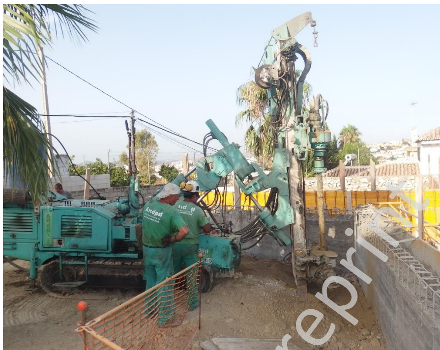
Lámina IV. Colocación de los micropilotes.
