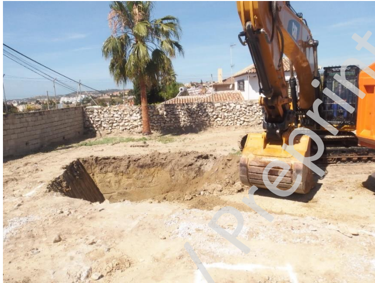
Lámina I. Inicio del rebaje por medios mecánicos del área libre de protección.
