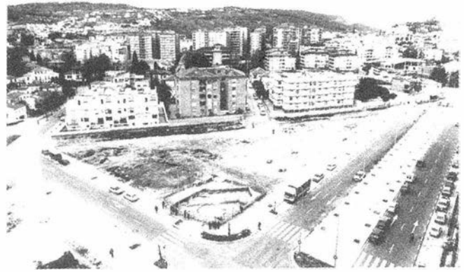
Panorámica del solar.
