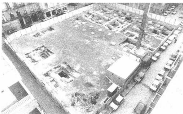
Panorámica del solar desde el Norte.
