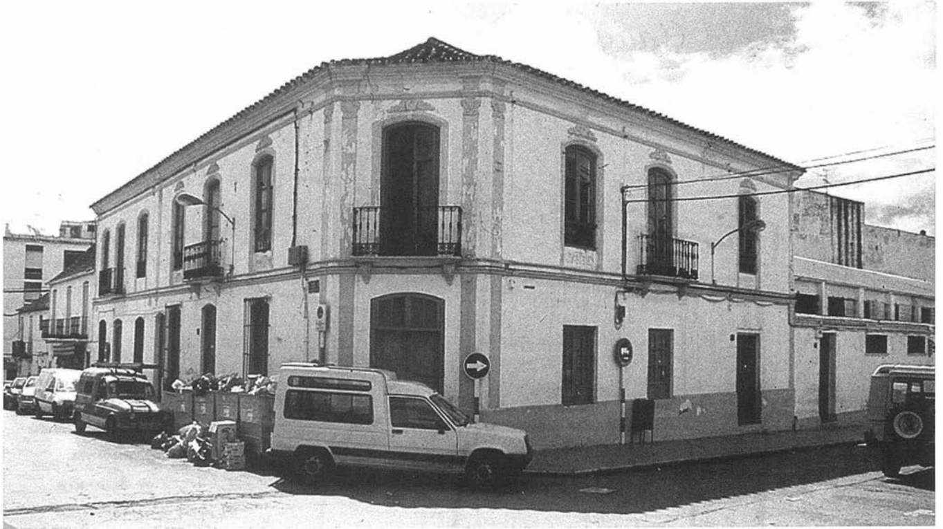
LAM. I. Casa Cañada antes del derribo.
