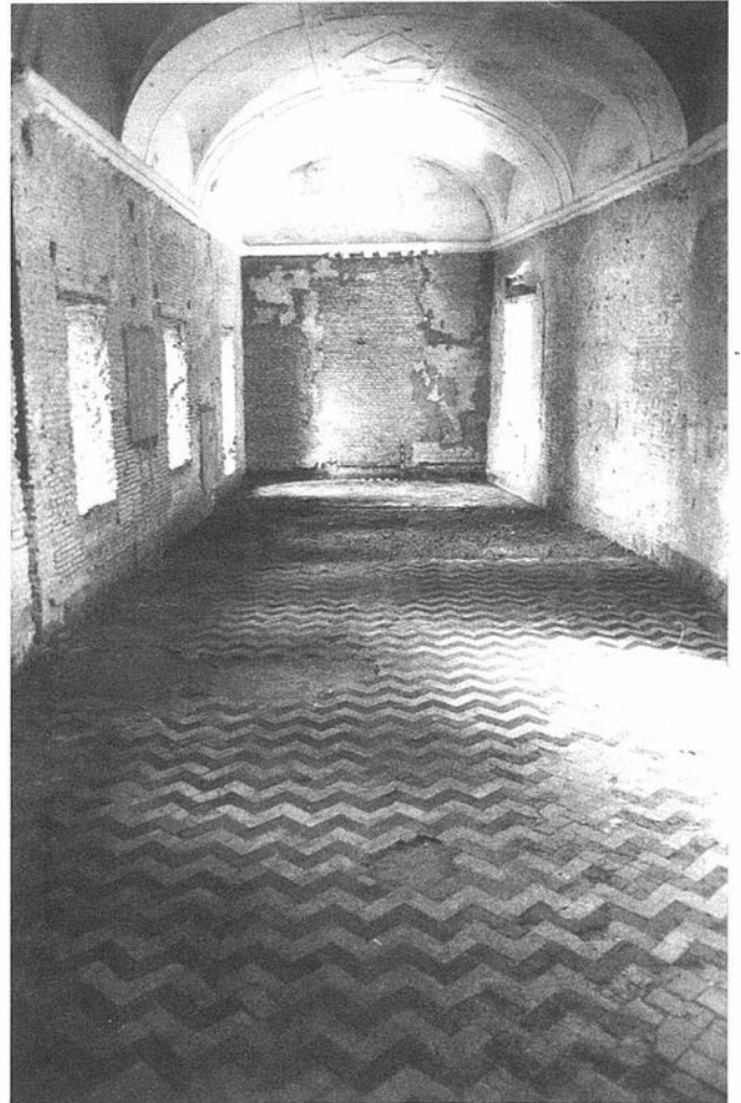
LAM. III. Recuperación del pavimento original, del s. XVII en la Sacristía.
