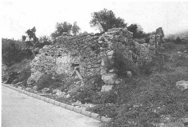
LAM. 1. Destrucción de algunas casas en el Barrio Alto de Benaocaz. 1ª Fase de pavimentación.
