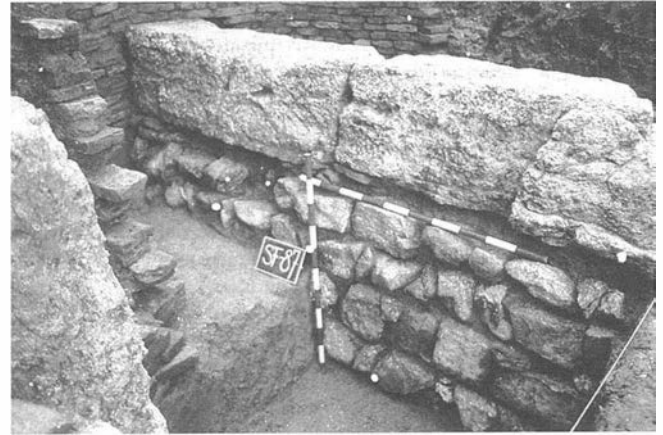
LAM. 3. Detalle del muro y cimentación. LAM. 4. Detalle del muro 7 y de la atarjea.
