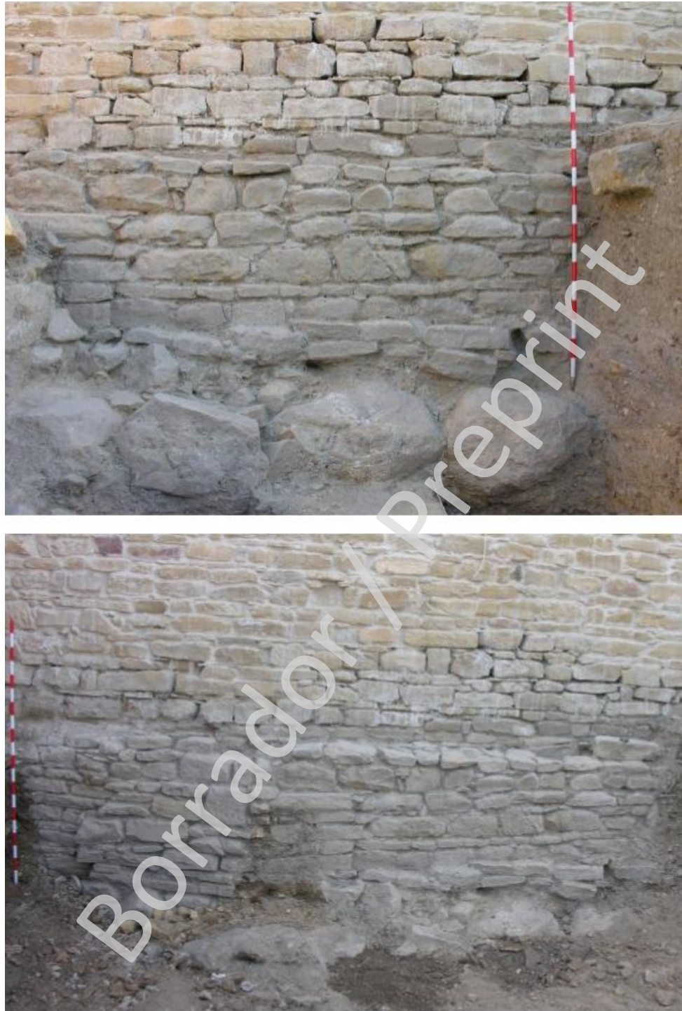
Fig. 4. Vista frontal del tramo de cimiento (UEC-LVI) de la Muralla de la Villa (GE-2) apoyada sobre una pequeña zarpa (UEC-LVII), que a su vez lo hace sobre lo que sería la cimentación (CE-6) de la Muralla Romana (GE-3) y vista frontal de la cimentación (E-19) de la Muralla de la Villa (GE-2), donde se pueden apreciar los tres tramos constructivos (UEC-LVI, UEC-LVIII y UEC-LIX) que la componen.
