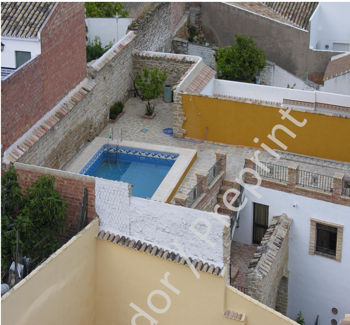
Fig. 12. Estado actual de la parte trasera de la vivienda, con la construcción de una piscina.
