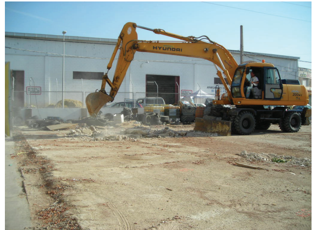
Fig.5. Retirada de la losa de hormigón con cazo de limpieza, una vez picado el contorno del sondeo 1.
