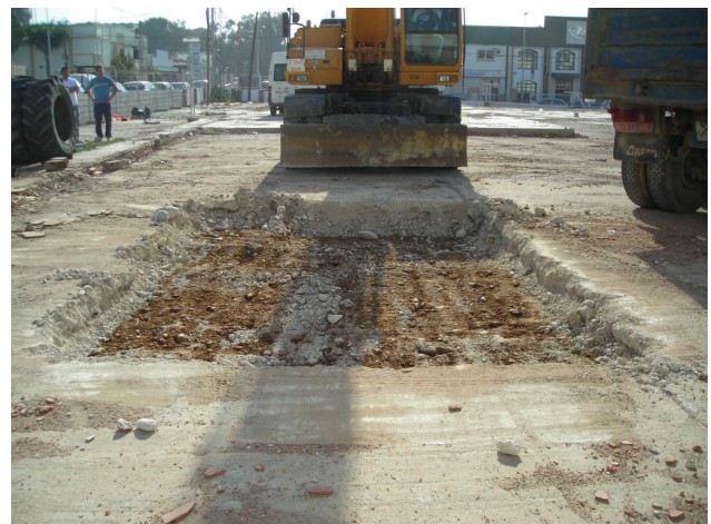
Fig. 6. Fin de la retirada del hormigón del sondeo 1, e inicio de la excavación mecánica del mismo.
