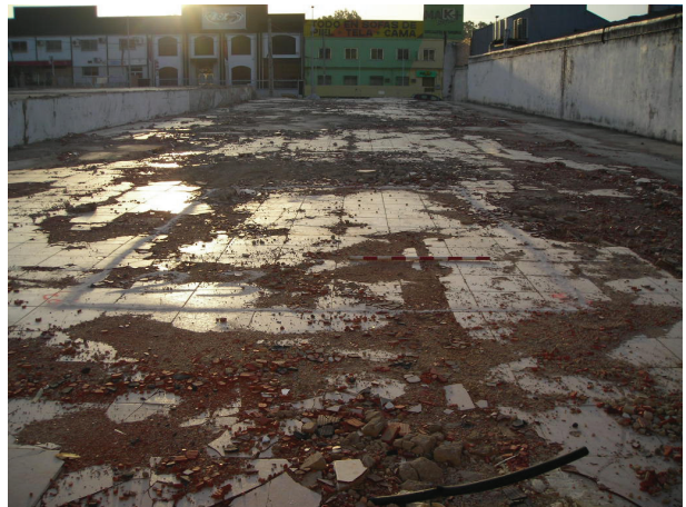
Fig. 3. Vista del solar desde el Oeste. En primer plano, replanteo del sondeo 23.
