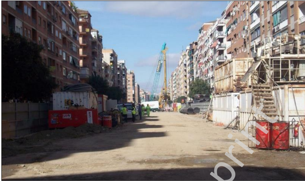
Inicio de los trabajos de pilotaje perimetral
