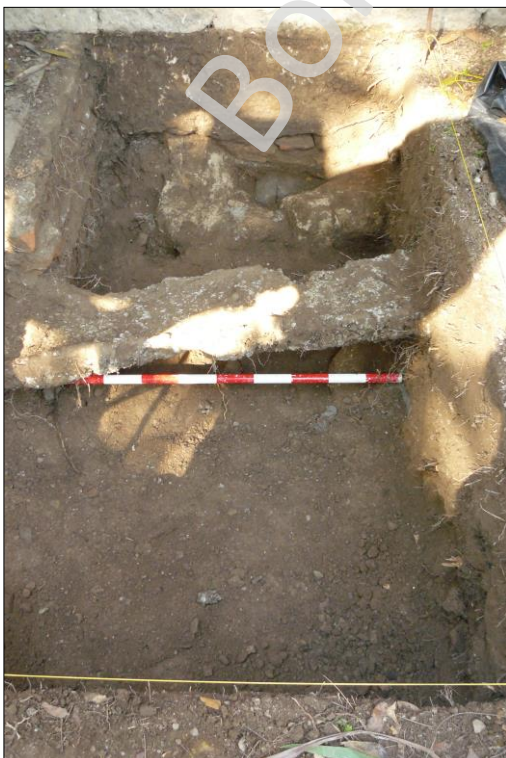
Imagen: Detalle de la instalación eléctrica y el relleno UE-002 de la C2.
