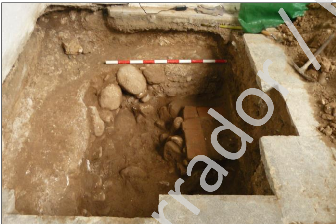
Imagen: vista de la zapata de cimentación y la UE-006.
