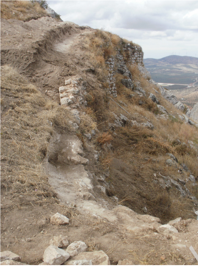
Fig. 3. Cabeceras y cara interior limpias entre las torres 1 y 3.
