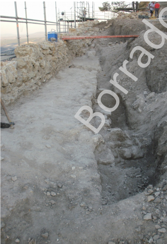
Inicio y final de la limpieza de la cabecera del tramo 15.
