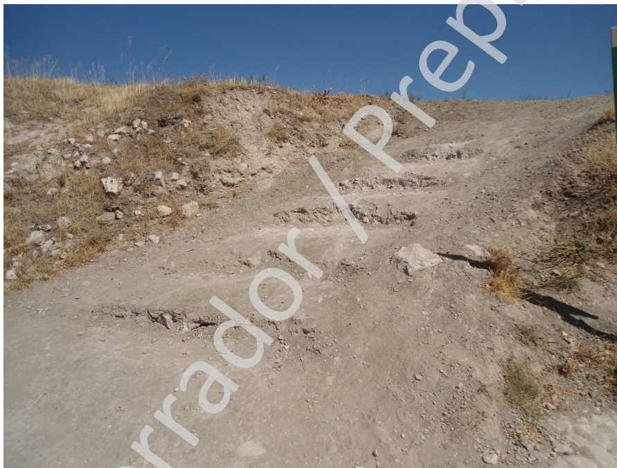
Camino de acceso original adaptado a la maquinaria. “Acondicionamiento” posterior.
