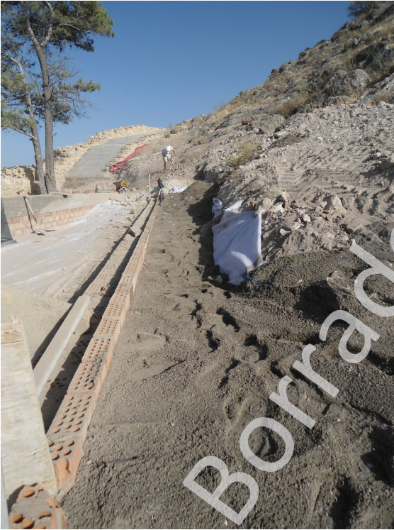
Cubrición de la nueva vivienda.
