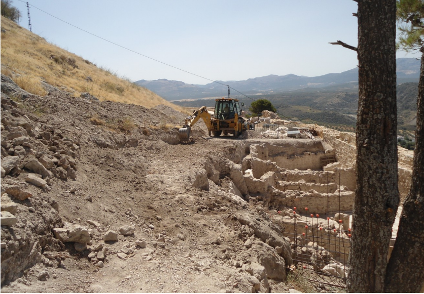
Preparación del camino tras la cata 1.
