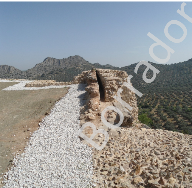
Camino de acceso original.
