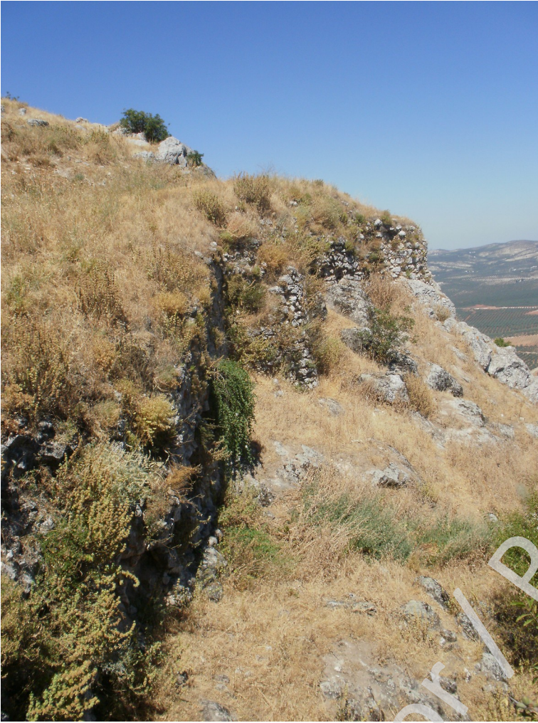
Estado previo a los trabajos.
