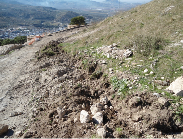
Detalle del rebaje de la ladera para el carril de tierra.
