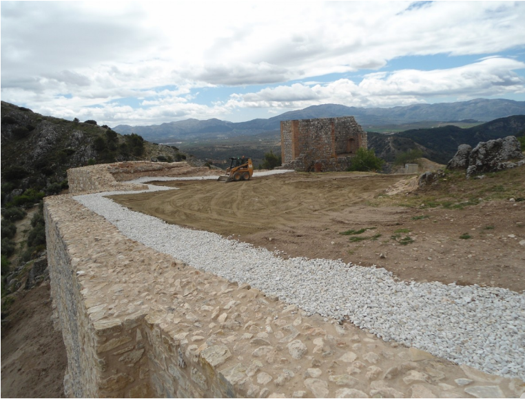
Trabajos terminados en el Sector 3.
