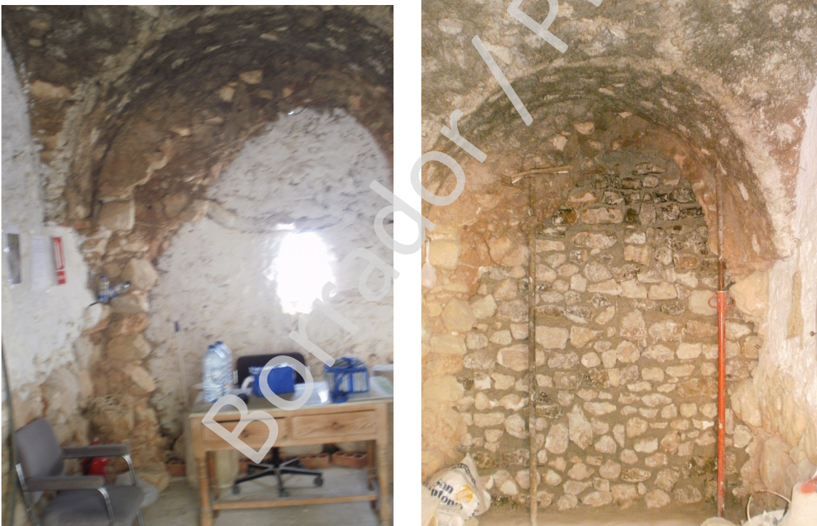
Interior de la Torre 7 antes y después de la restauración.
