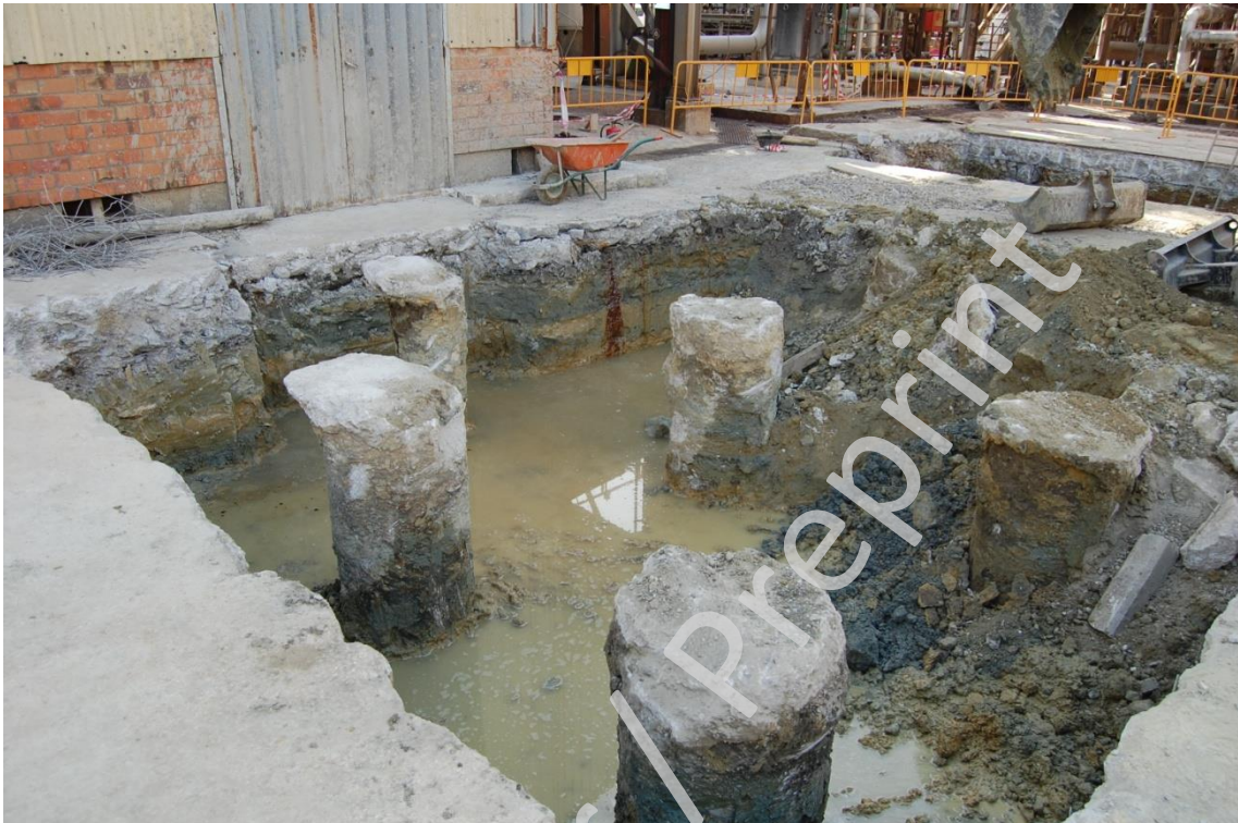
Lámina 3. Excavación en la nueva turbina de vapor y condensador
