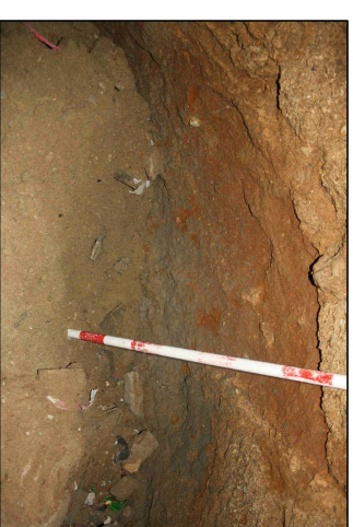
CATA FONDO POZO
