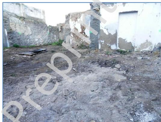
En cuanto al proceso seguido durante la excavación del solar, tras el derribo de las estructuras de la vivienda preexistente y limpieza de escombros, se procedió a la excavación de la parcela por medios mecánicos mediante una máquina retroexcavadora tipo giratoria, para los rebajes en la zona frontal y carga de acopios, apoyada por máquina retroexcavadora pequeña, para aquellos espacios de menor tamaño en la zona trasera y de mayor dificultad de acceso y movilidad.
