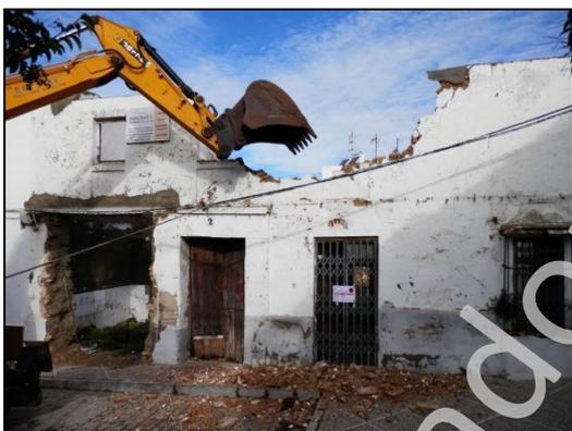
Estos trabajos de demolición fueron controlados por el equipo técnico de arqueólogos de forma esporádica, con el fin de poder tener una mejor visión de la composición del inmueble demolido y mayor información sobre el posicionamiento de los espacios estructurales interiores y las cimentaciones de las unidades constructivas que posteriormente íbamos detectando durante los rebajes en el subsuelo.
