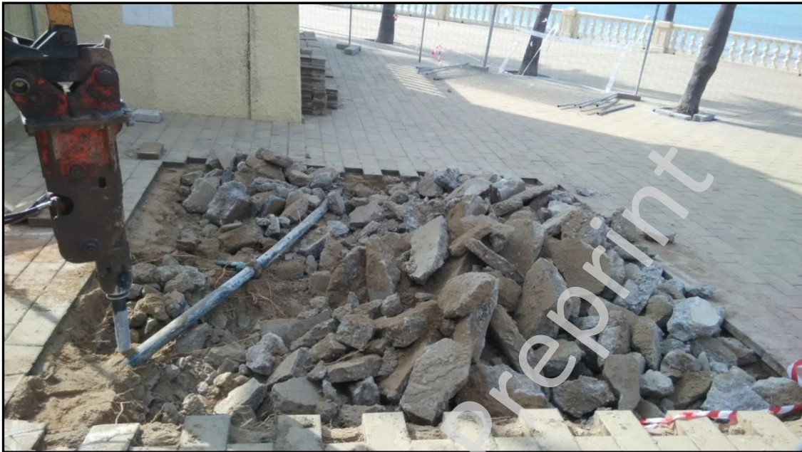
Fig. 7. Retirada de la solería y hormigón del sondeo
