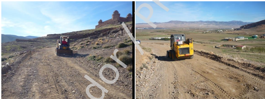
Proceso de trabajo acondicionamiento y control arqueológico del camino.
