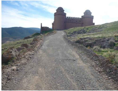
Vista general del camino, tras los trabajos realizados.
