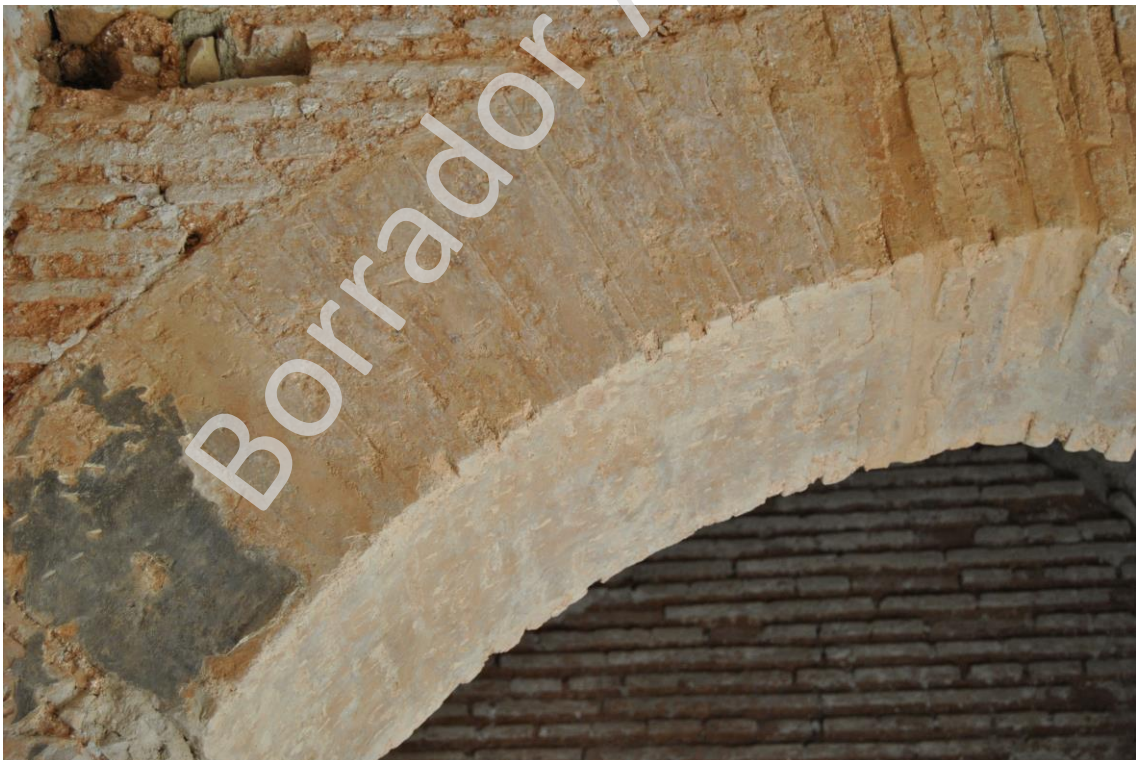
Lam. 7 Enlucido y pintura original en el arco entre las salas 1 y 2.
