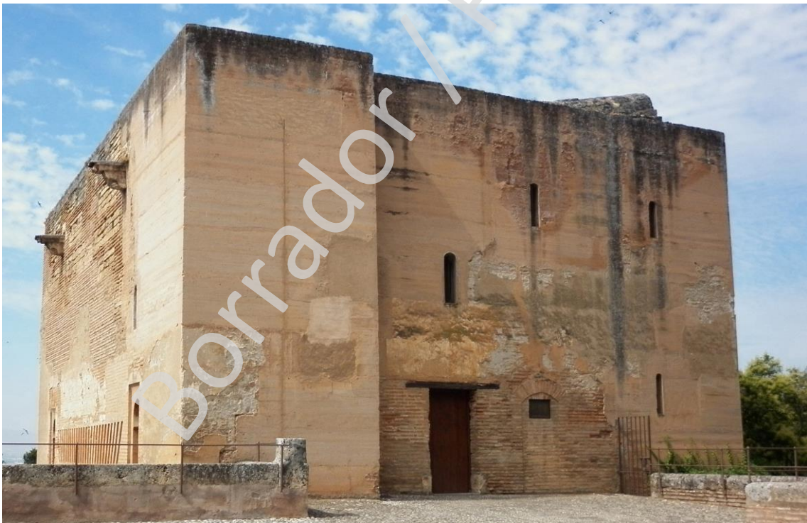
Lam. 1 Fachada norte de la Torre de la Justicia.
