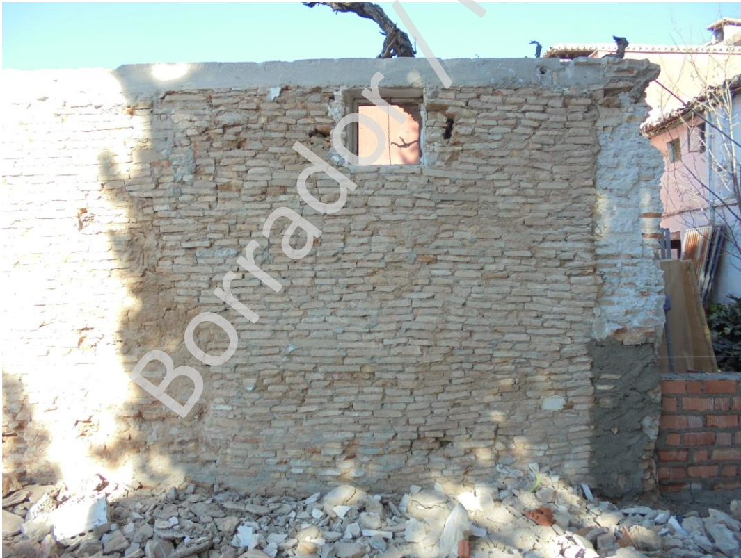
Lám. 4. Vista interior de una porción del muro que linda con la placeta. En la zona sombreada se puede apreciar la parte de muro reconstruida para tapiar el solar antes de la construcción de los talleres.
