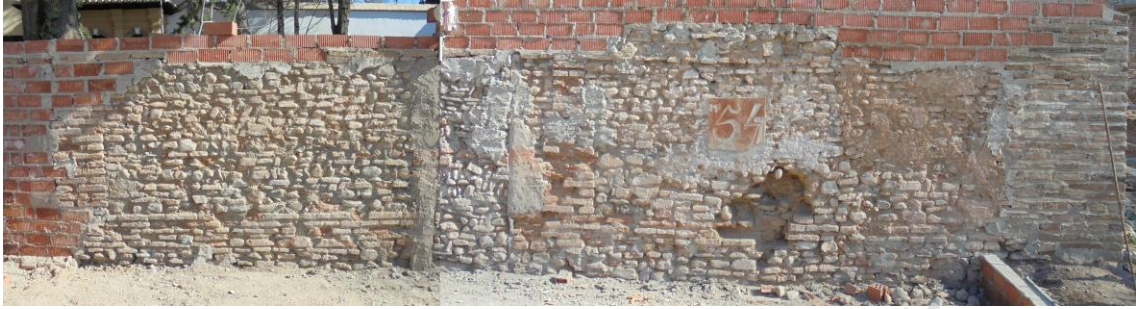
Lám. 5. Muro medianero de la pared que delimita con el patio trasero de la casa de la Calle Real
