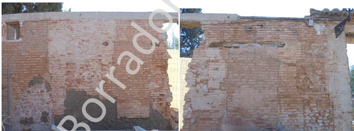
Lám. 3. Dos lienzos de muro que delimitan con la Placeta de los Álamos. En cada una de ellos se aprecian los dos vanos cegados con aparejo de ladrillo y el corte para estructurar el acceso a los talleres.
