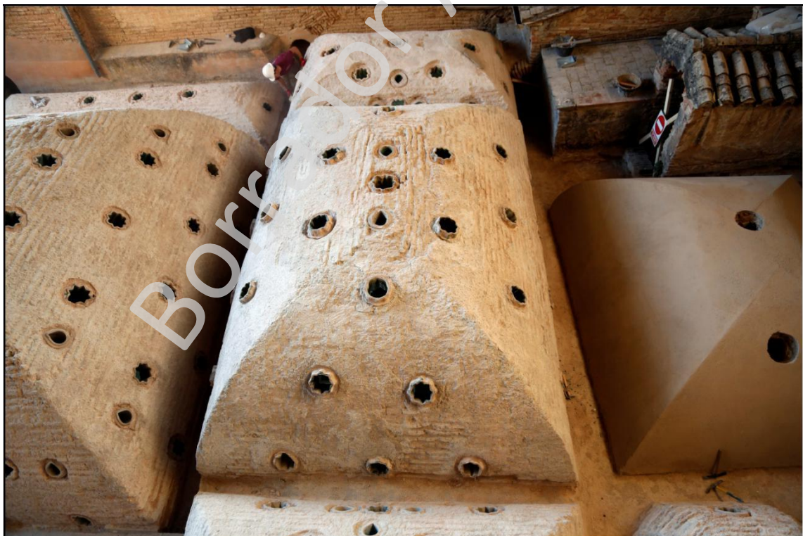
Imagen: Vista desde el oeste de la bóveda principal de la sala caliente C -02, se observan las lucernas, diferentes al resto, sobresaliendo del plano de la bóveda.
