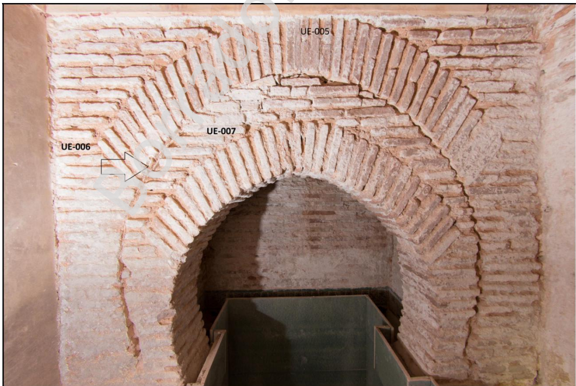
Imagen: Detalle de las dos fases en el arco de herradura de la pileta de mármol en F-01 (Foto: Pepe Marín).
