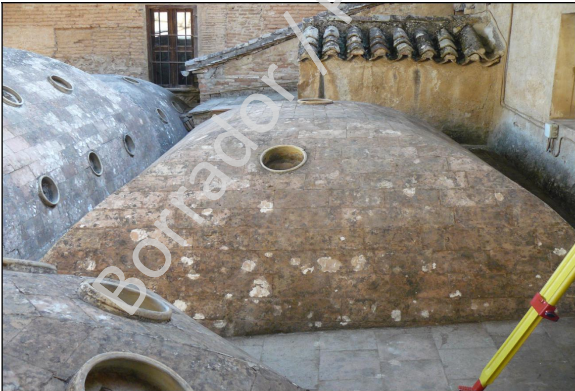
Imagen: H-01 cara oeste (cámara de fuego) con el forrado de plaquetas UE-001
