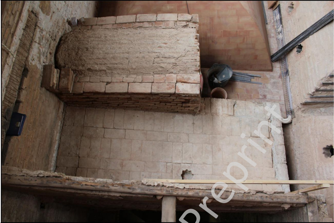
Imagen: Vista de las cubiertas H-02 y H-03 ya retiradas las fases contemporáneas.
