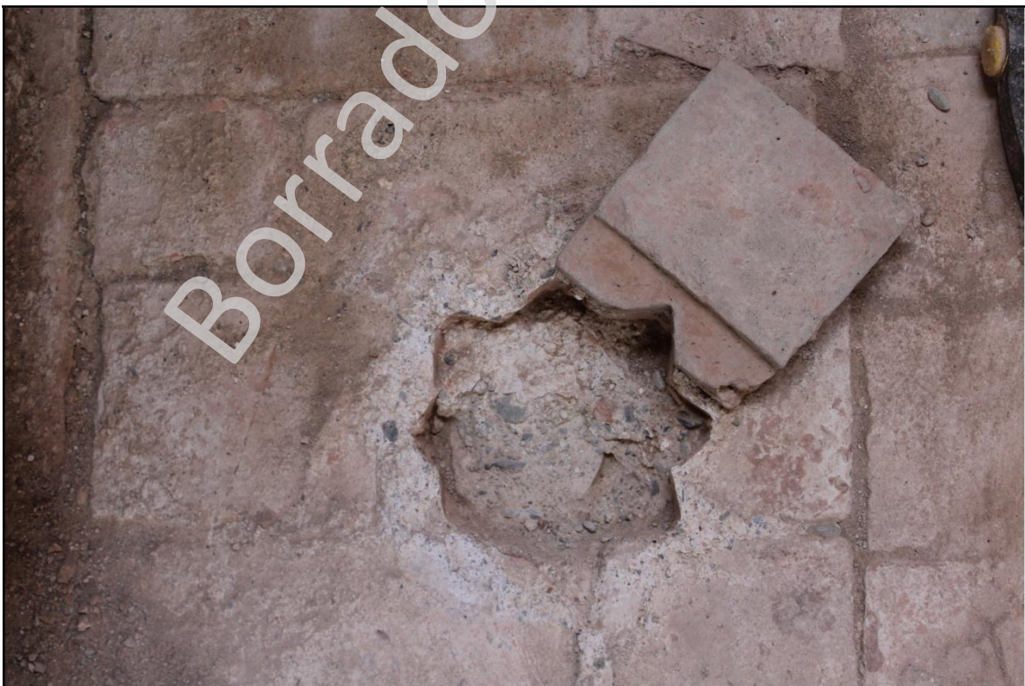
Imagen: Detalle de la ventilación de H-03, taponada y posible pieza cerámica asociada.
