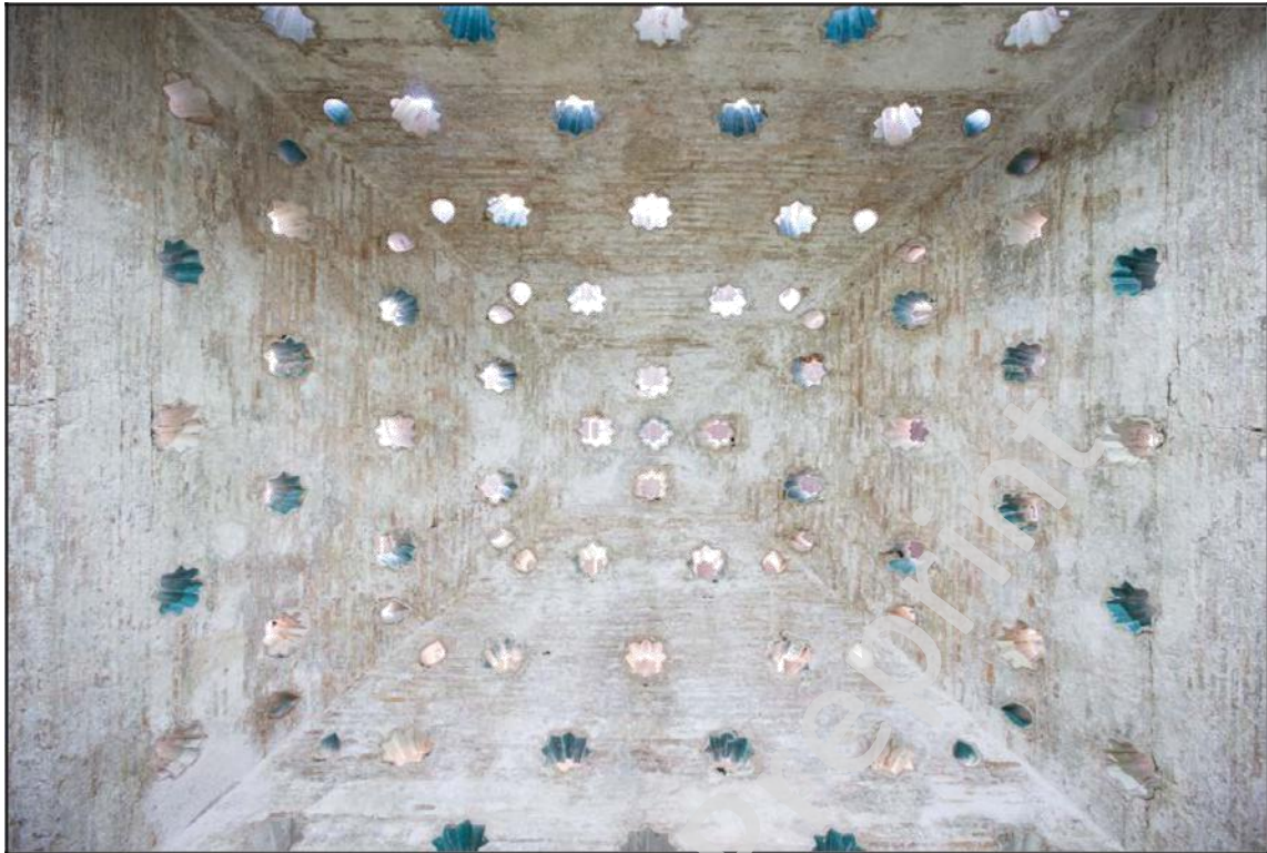
Imagen: Bóveda central de la sala templada, T-02, conserva restos del enlucido de cal. (Foto: Pepe Marín).
