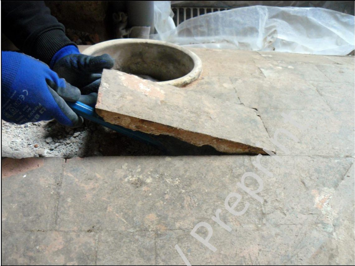
Imagen: Trabajos de retirada de las plaquetas del forrado decimonónico.
