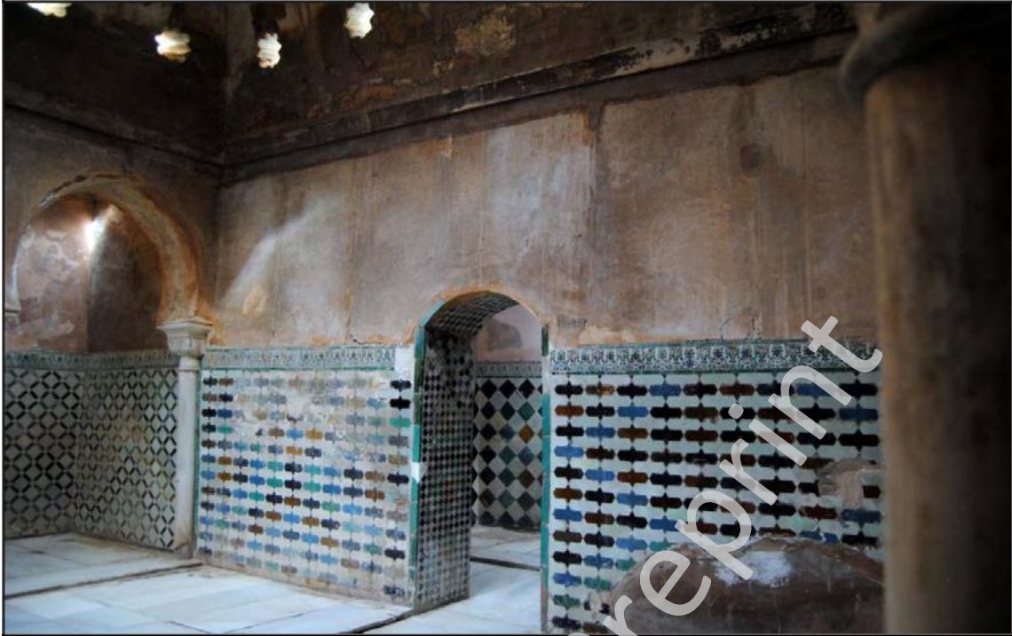
Imagen: Vista de los enlucidos del interior del baño antes del proyecto de restauración.
