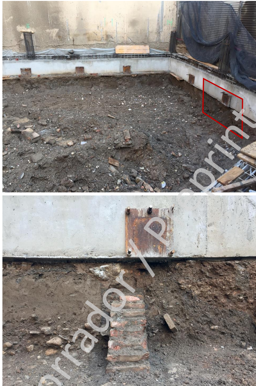
Figura 2. Arriba: aspecto del extremo E del solar al comienzo de la primera cava; abajo: detalle de la estratigrafía en el perfil E, bajo la viga de coronación.
