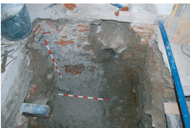
4. Detalle de la estructura hidráulica, una vez que descartáramos que se tratara de una estructura muraria antigua de la vivienda
