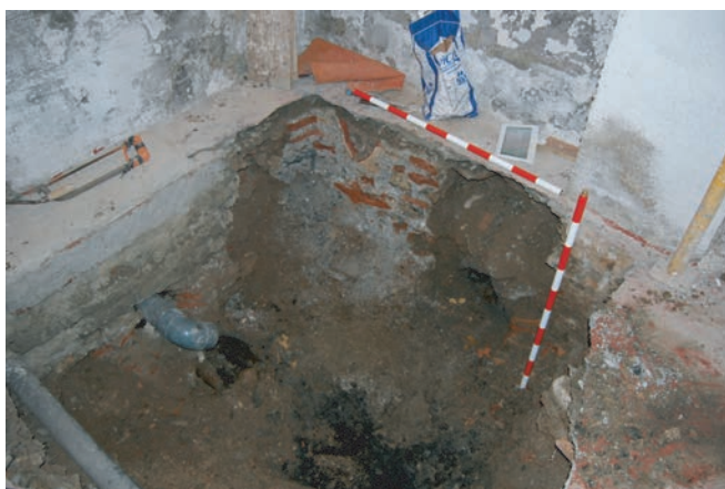
2. El sedimento extraído presentaba en algunos puntos un color negruzco resultado de años de filtración de residuos de las antiguas tuberías
