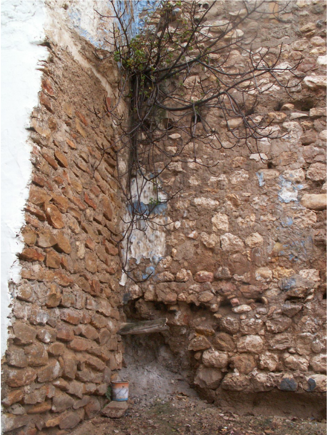
Lámina 4. Conservación de lienzos de muralla medieval en los alrededores de la Plaza la Lonja de Quesada, Jaén
