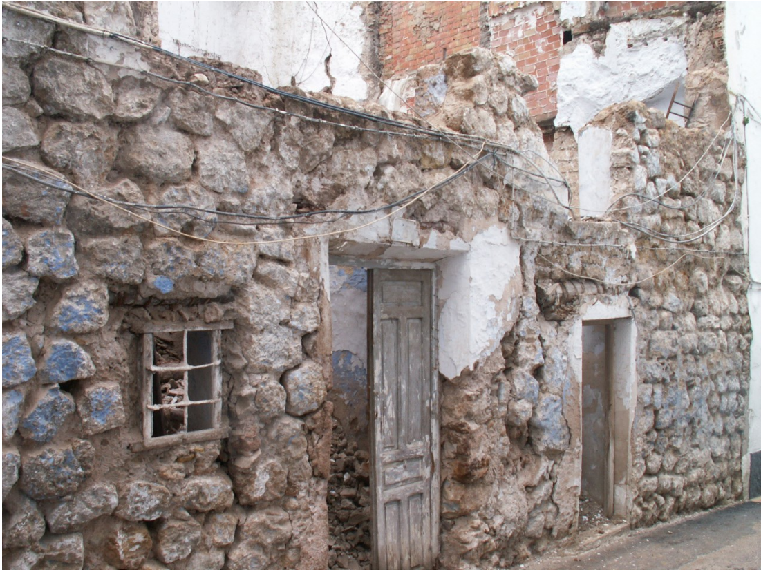
LAMINA 2. Panorámica de la fachada de los inmuebles 45-47 tras los trabajos de retirada de capas de enlucidos y cal
