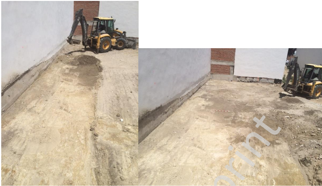
Proceso de raspado y limpieza.
