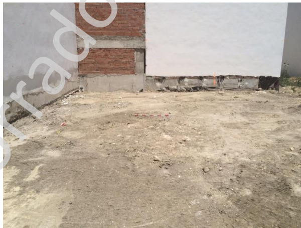
Acondicionamiento de la zona Norte. Nivel de cota.
