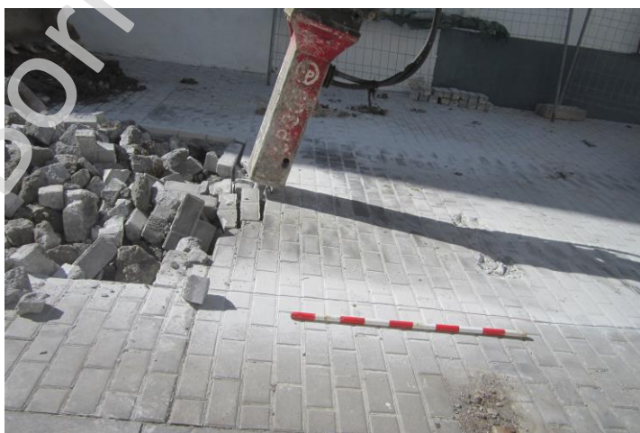
Desmante del acerado de la calle (unidad constructiva 1 y unidad constructiva 2)
