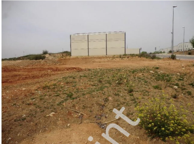
Lám. XII.. Vaciado para construcción nueva. Sector 7.
