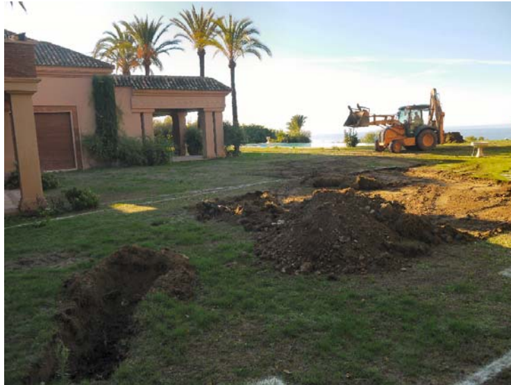
FIGURA 5. VISTA FINAL DE CALICATAS
