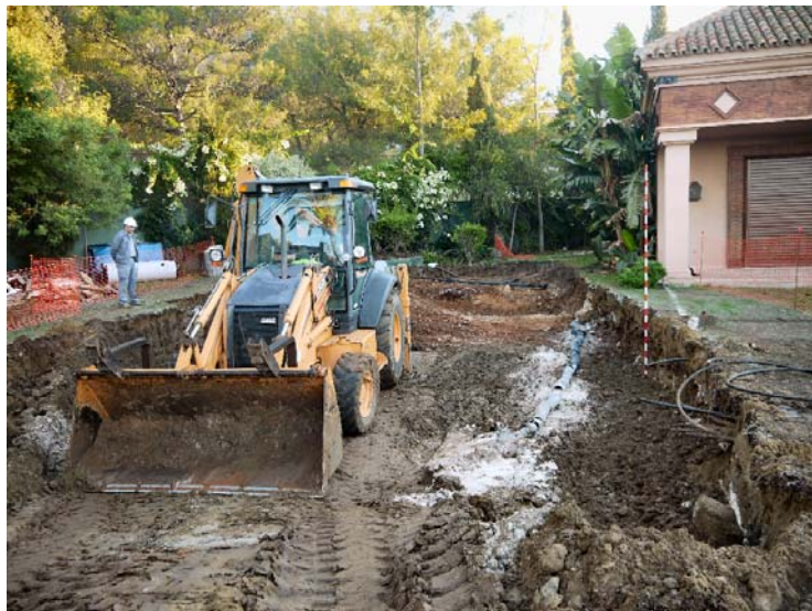
FIGURA 6. VISTA DESDE EL SUR DE LA RETIRADA DEL NIVEL DE RELLENOS (UE-2)
