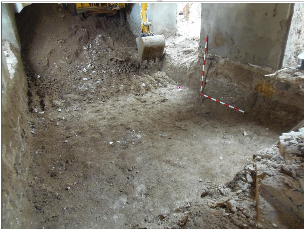
Lámina IV. Resultado del vaciado de tierras en la crujía 1.
