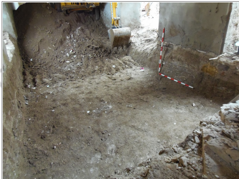
Lámina II. Máquina empleada para el vaciado de tierras.
