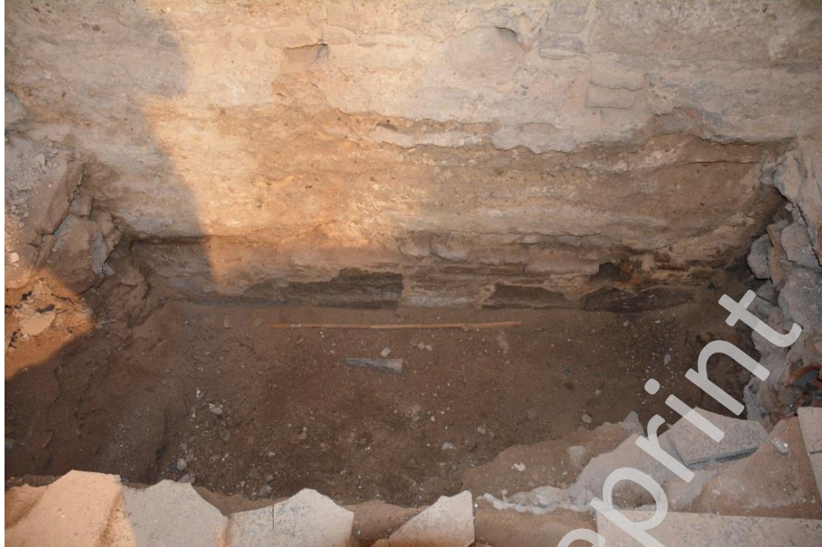
Lámina II: la cimentación del muro documentada en la cata.
