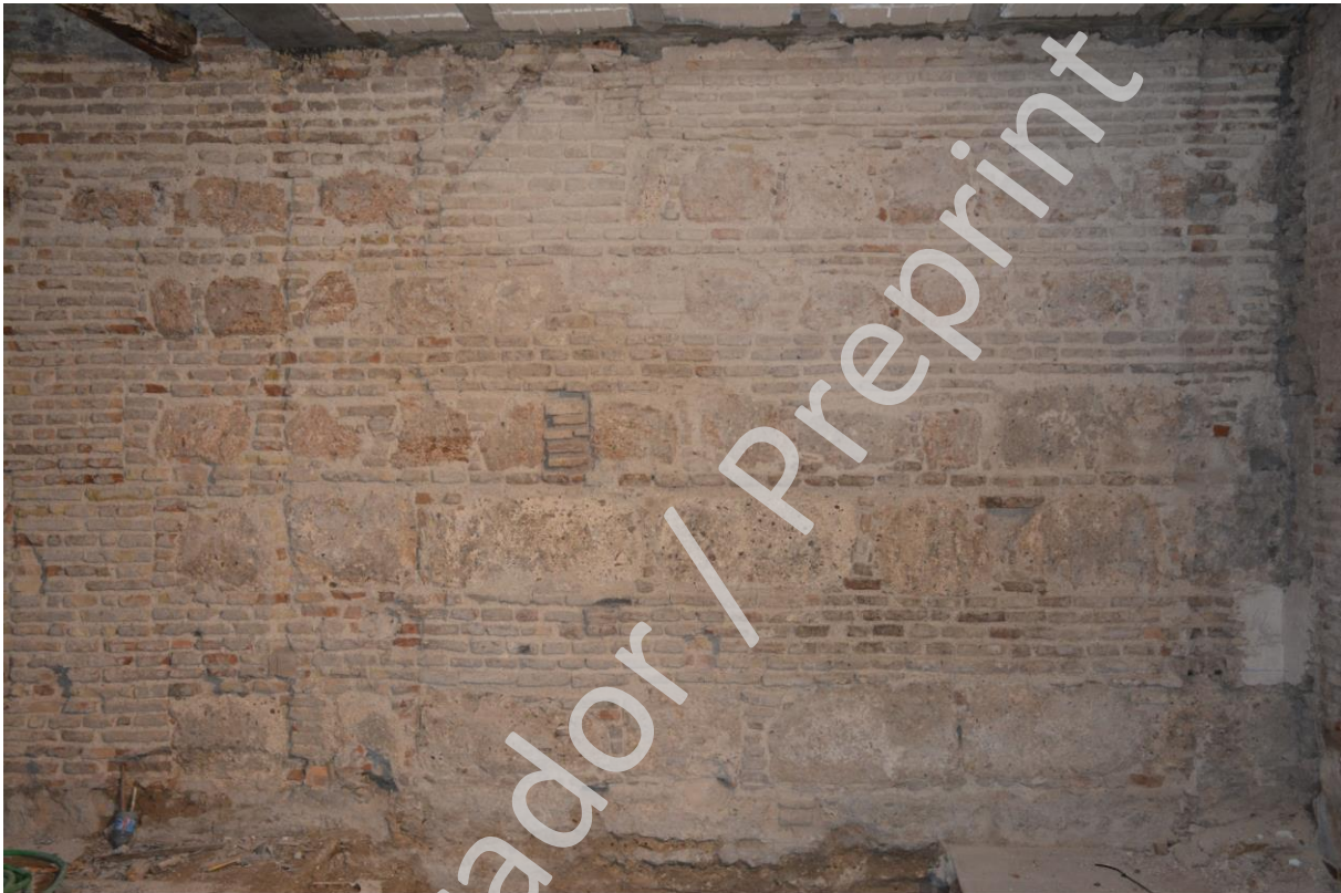
Lámina I: el muro tras el picado
