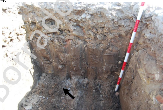
Lámina 5: Vista general del perfil oriental del sondeo n° 9, tras finalizar los trabajos de excavación
