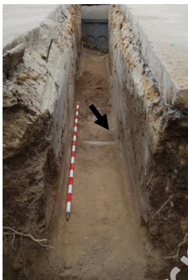
Lámina 2: Vista de la zanja de conexión de las arquetas n° 1 y 2 una vez finalizados los trabajos de excavación mecánica.
