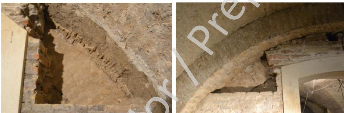
**Láminas 17 y 18.** Detalle del arco diafragma que une y sirve de transición entre la sala 3 y 2, uniendo solidaria y coetáneamente ambas bóvedas.
