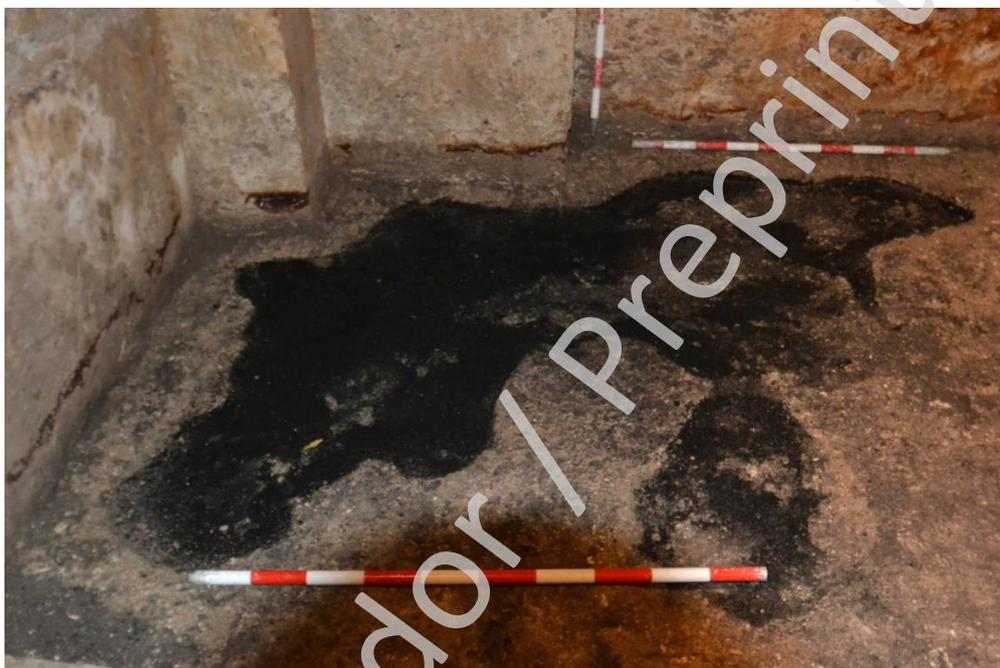
**Lámina 36.** Detalle de la ruptura en el pavimento dejando al descubierto la capa de ceniza de su preparación.
