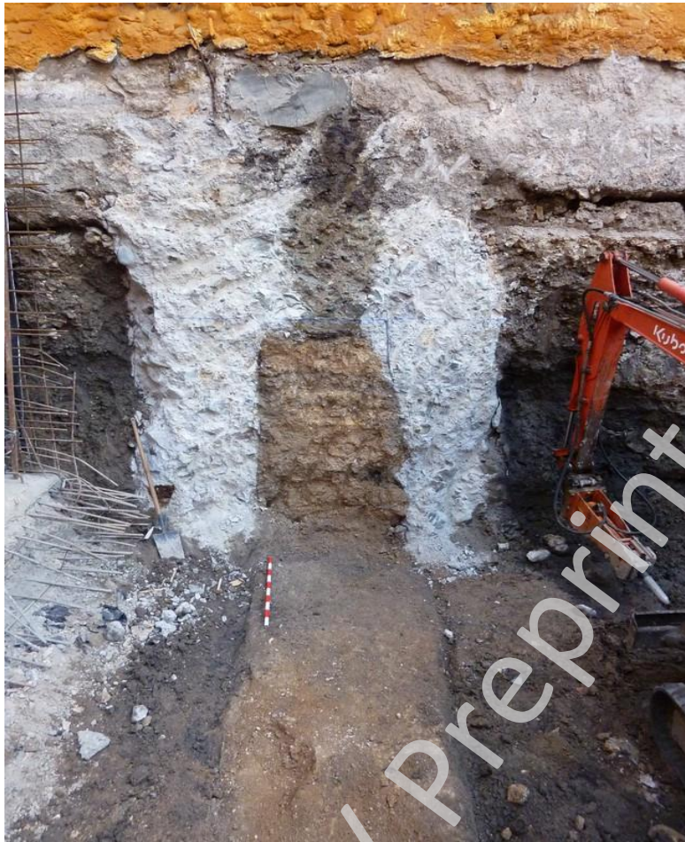
La barbacana embutida en la zapata de hormigón del siglo XX.
